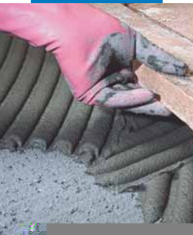
Kézzel készített terracotta lapok ragasztása egyenetlen aljzatra
