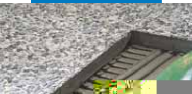
Kézzel készített terracotta lapok ragasztása egyenetlen aljzatra
